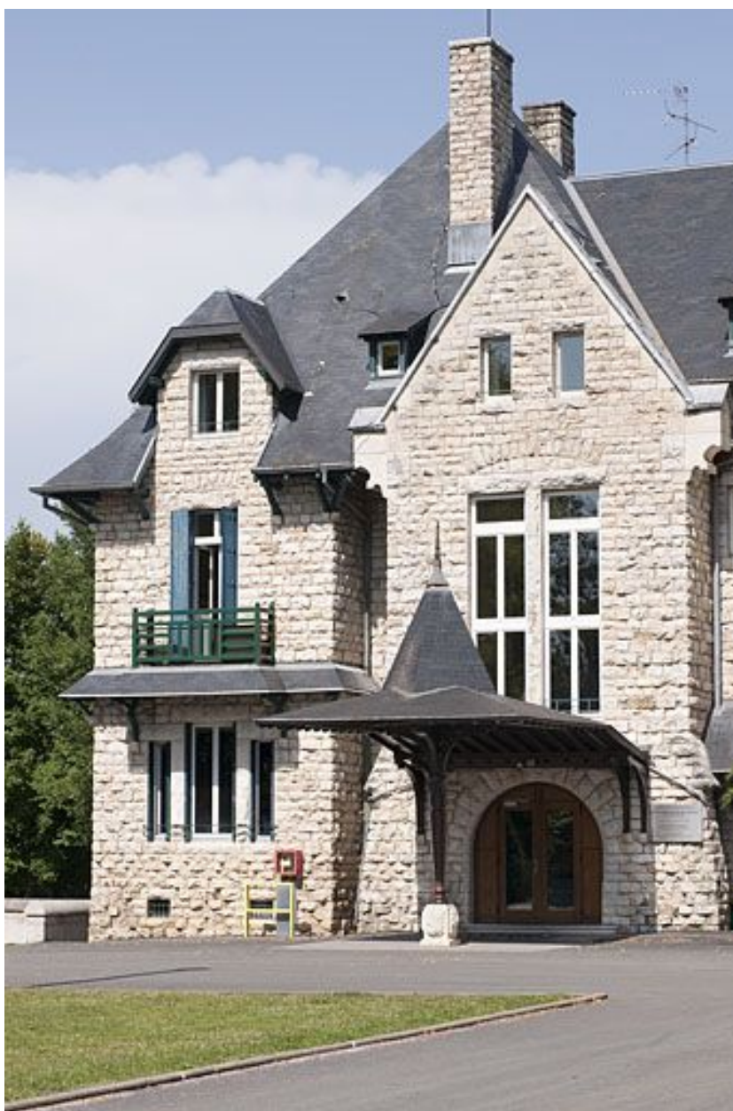
Partie nord de la façade antérieure.
