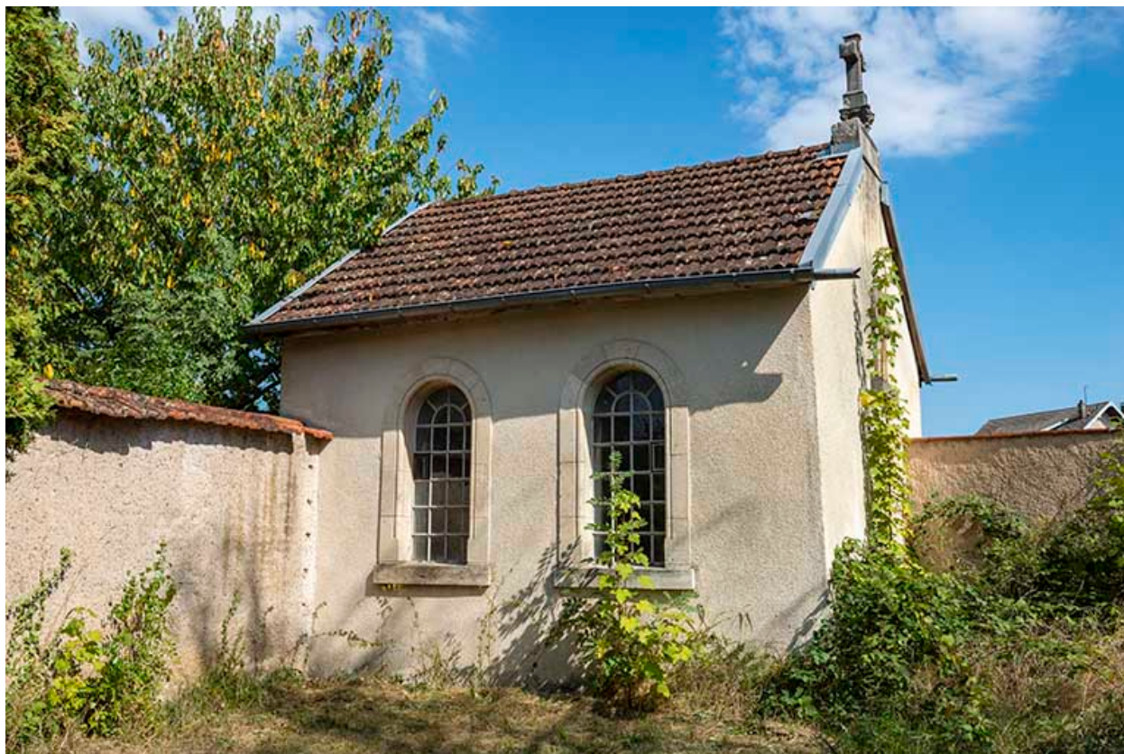
Vue depuis le sud-ouest.
