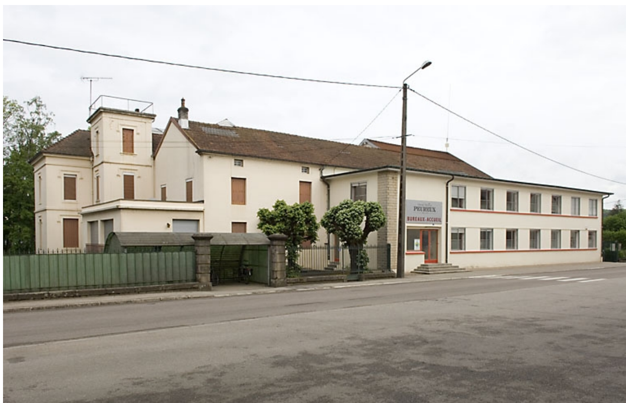
Ancien logement patronal et bureau.
