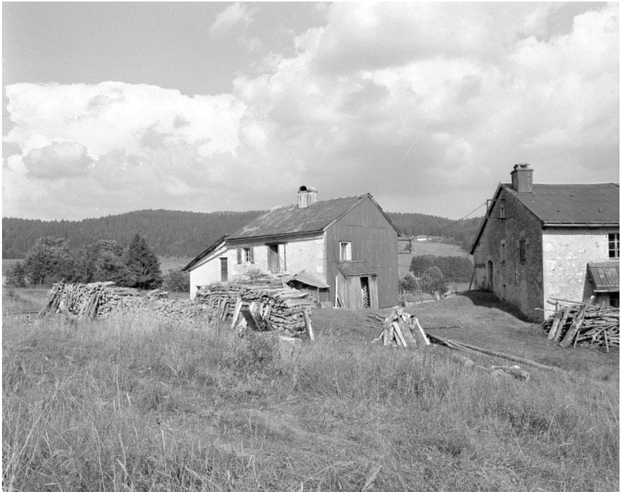
Façade postérieure et face gauche de la maison de douaniers, recouvertes d'un essentage de tôle.
