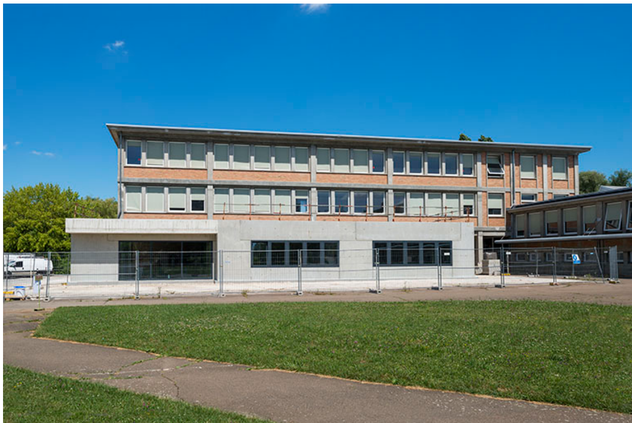
Façade antérieure sud de l'externat (ex-Léger)
