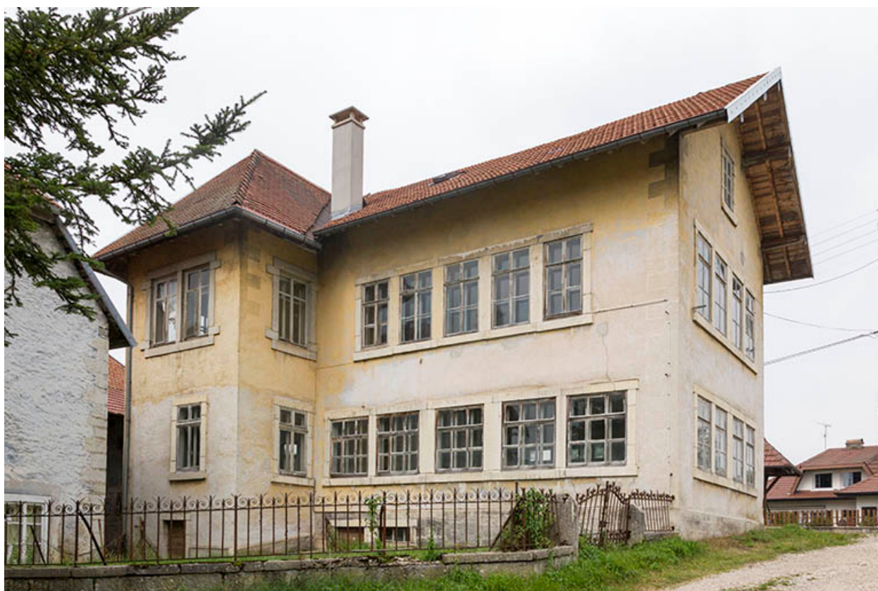
Usine : façades postérieure et latérale gauche.
