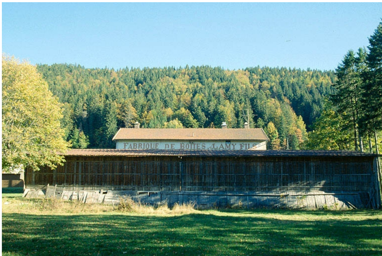
Façade postérieure du séchoir.
