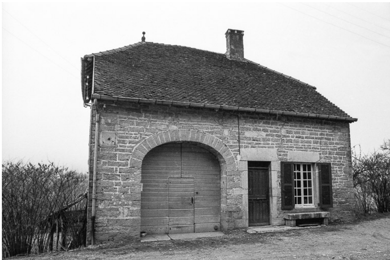
Ferme cadastrée 1965 AD 119 : façade antérieure.
