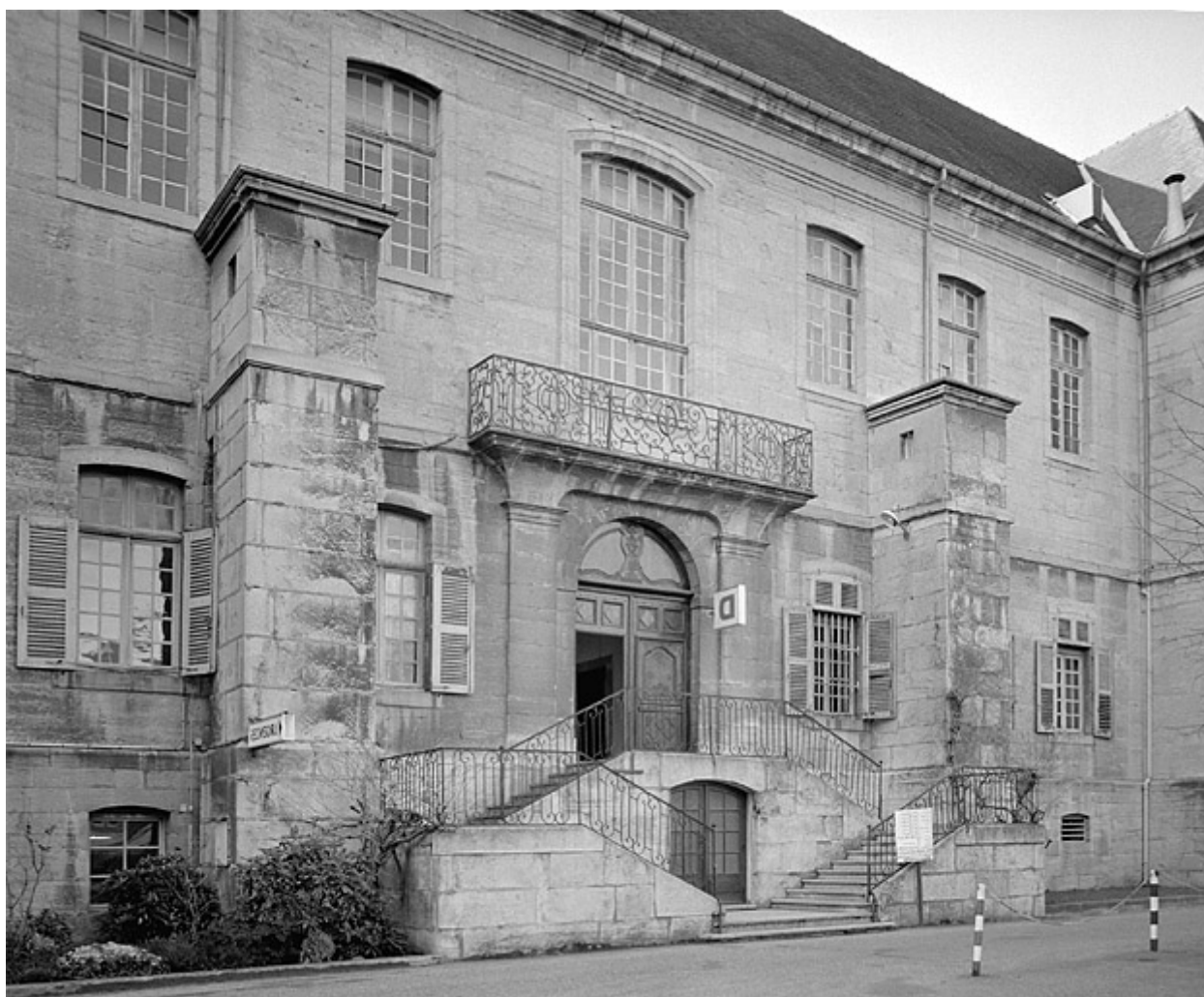
Façade postérieure, escalier extérieur.
