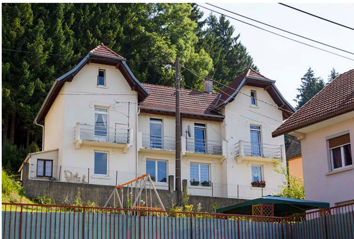
Immeuble au n° 1 : façade côté vallée (ouest).
