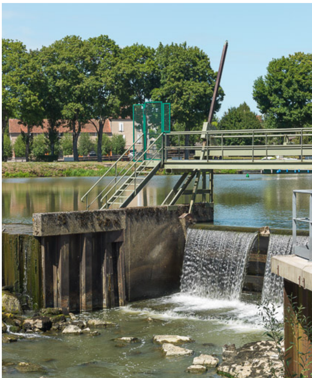
Vue du déversoir.
