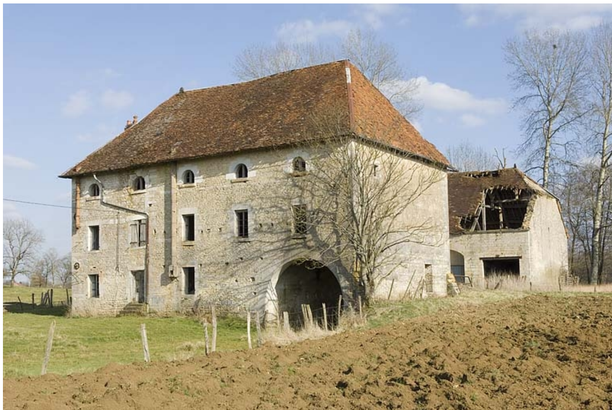
Vue depuis l'ouest.
