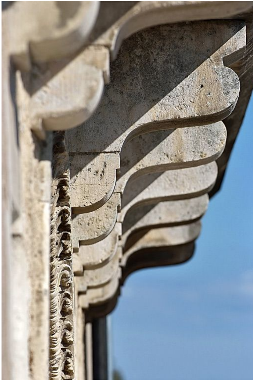
Consoles supportant le balcon de la façade rue du Château.
