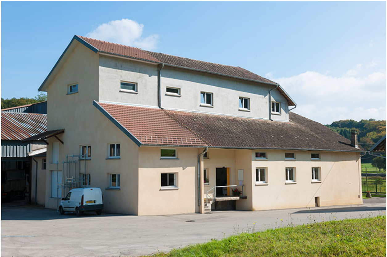
L'atelier du moulin, depuis le nord-est.
