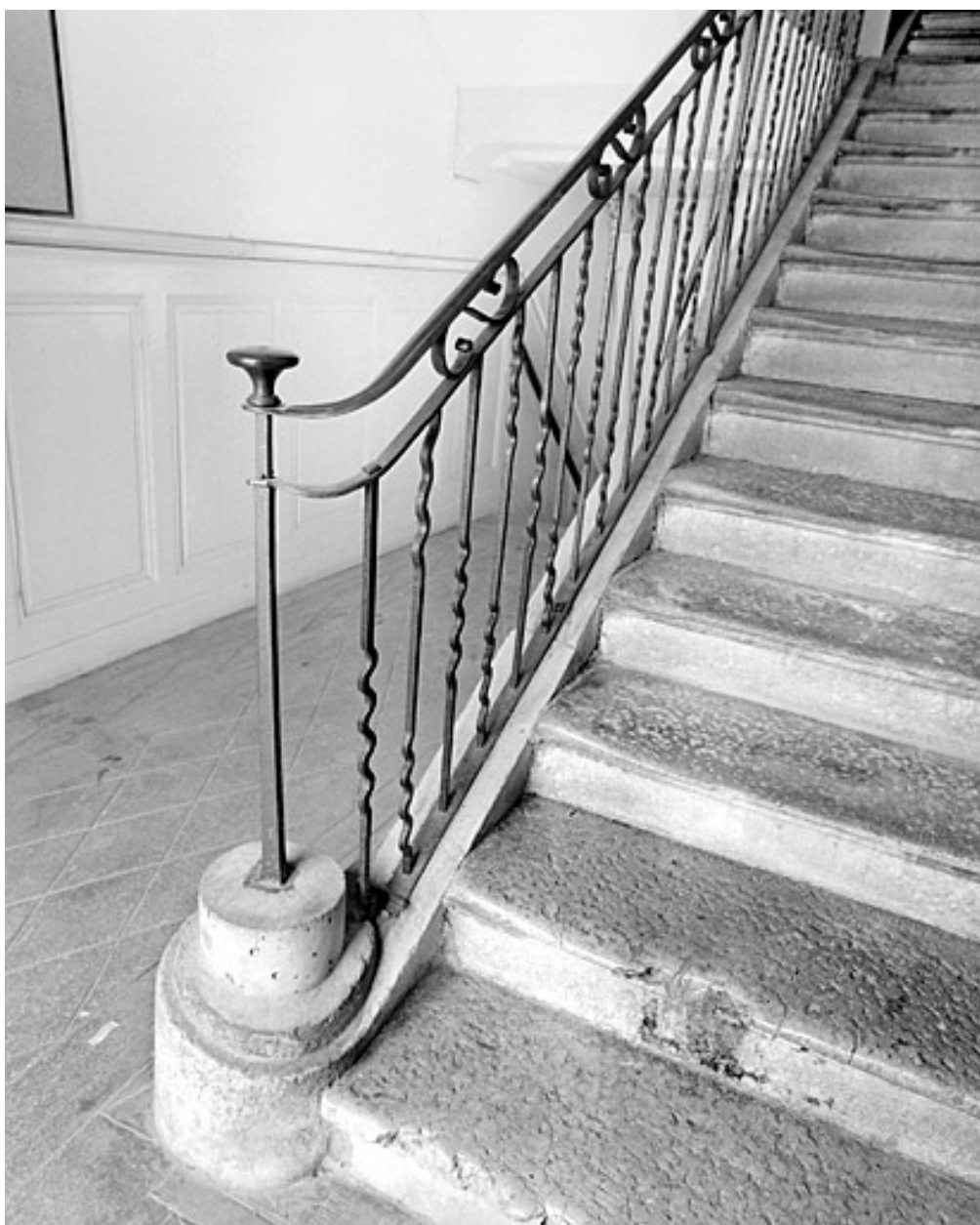
Rampe et départ d'escalier.
