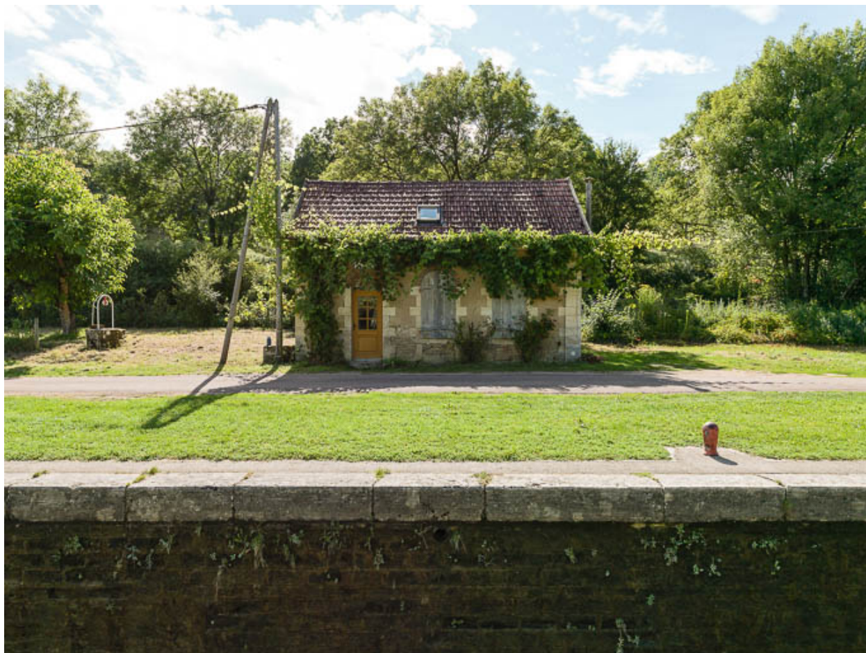
VUE du sas et de la maison éclusière.
