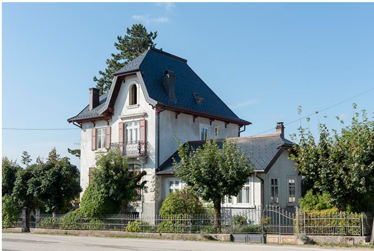
Façades antérieure et latérale droite.
