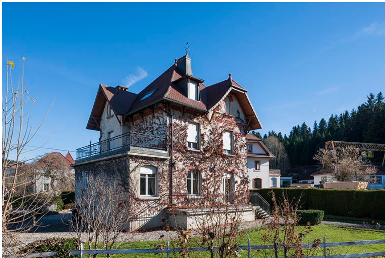
Villa Mascotte : façades postérieure et latérale droite.
