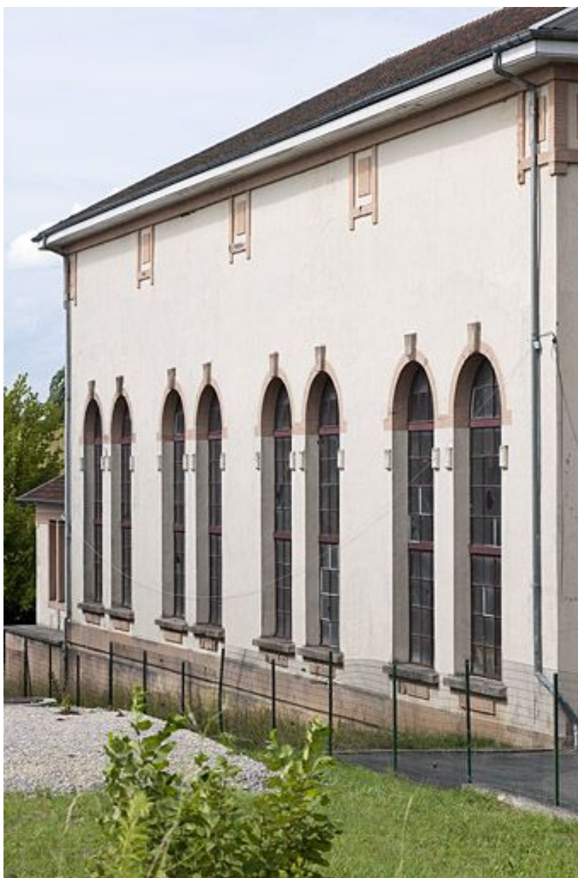
Façade ouest de la salle des machines.
