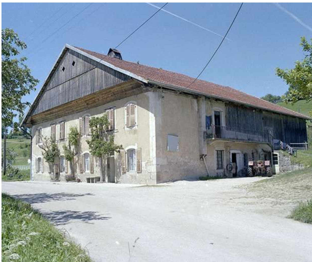
Ferme située rue du Canal.
