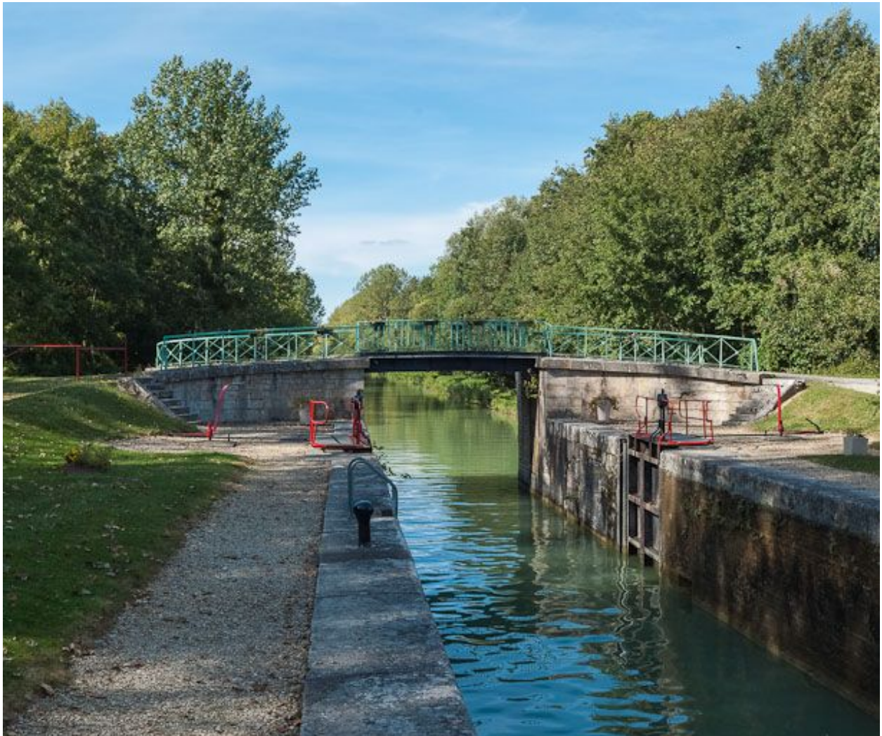
Vue du pont depuis le sas.
