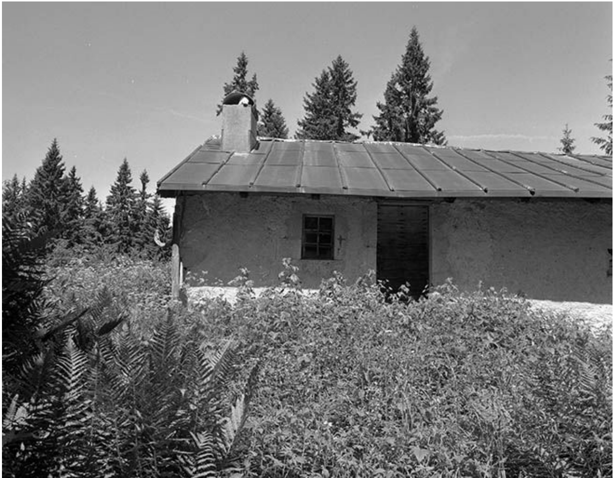
Porte d'accès de la façade antérieure.
