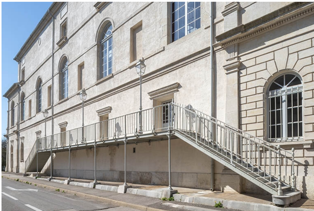
Corps central : façade latérale gauche.
