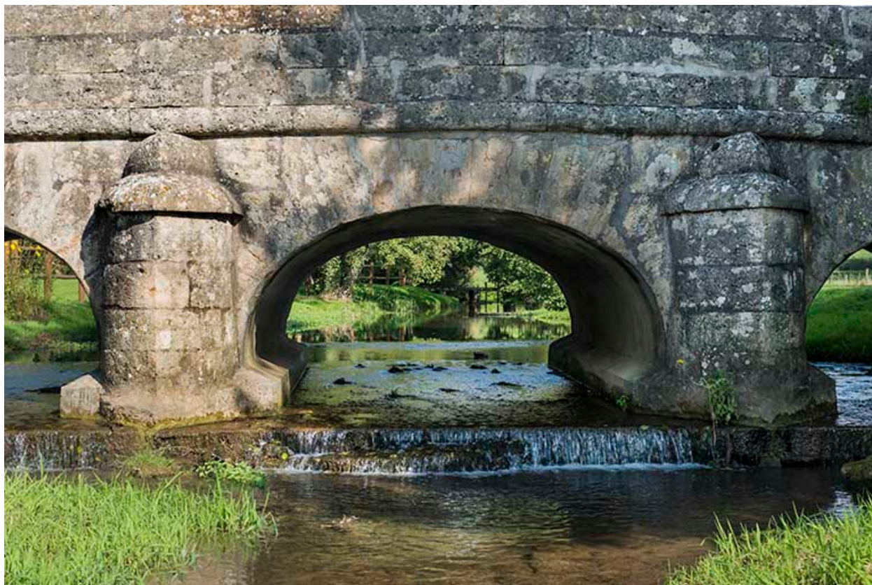
La voûte centrale.
