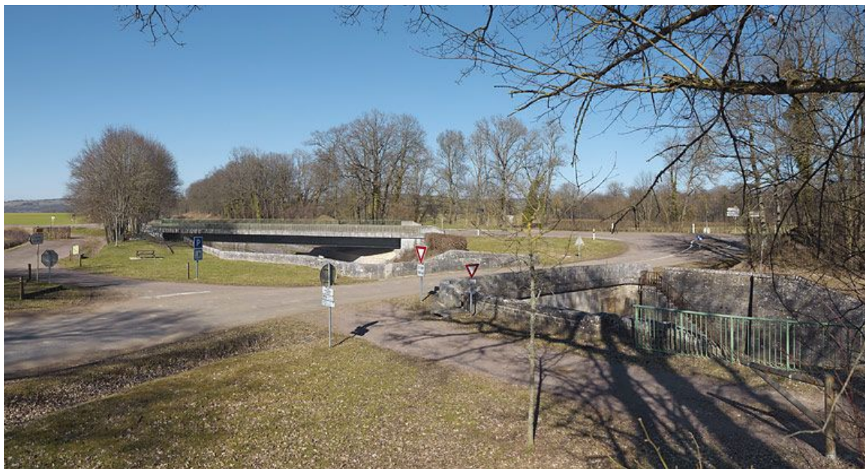
Vue d'ensemble des deux ponts.
