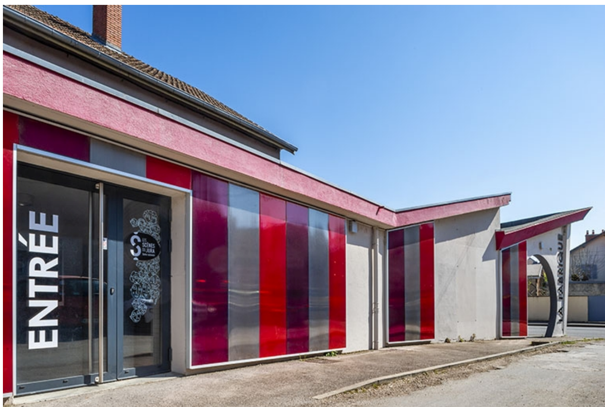
Façade latérale gauche : entrée et vestibule.
