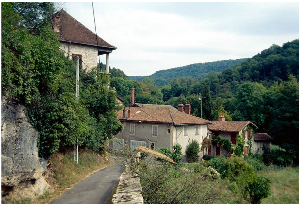
Logements vus de l'ouest.
