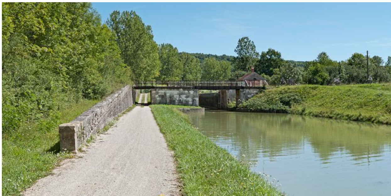
Vue du pont ferroviaire depuis l'aval.
