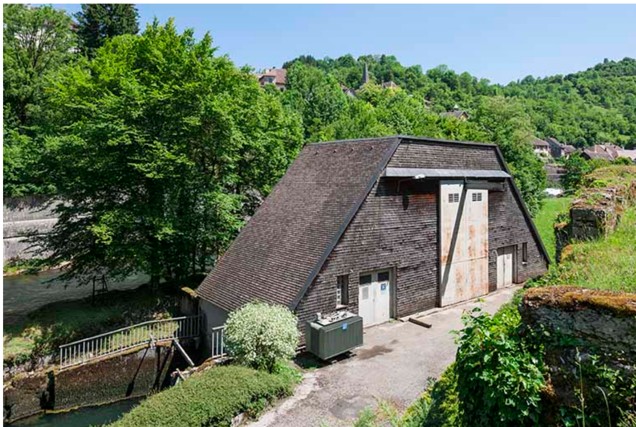
Forges de Lods, actuellement centrale hydroélectrique, Lods.
