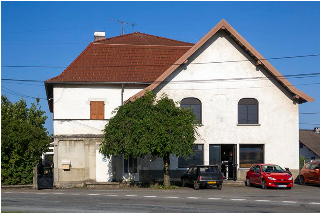
Atelier de fabrication : façade antérieure.
