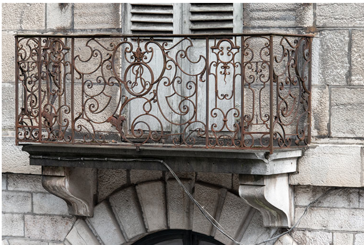
Ferronnerie du balcon (1er étage).
