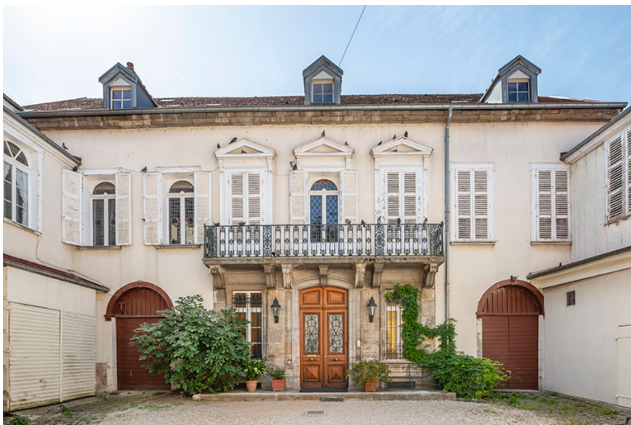
Façade sur cour. Vue de face.
