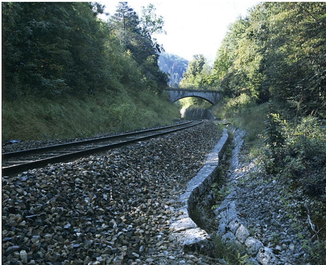
Vue d'ensemble, depuis le côté Andelot-en-Montagne (nord).
