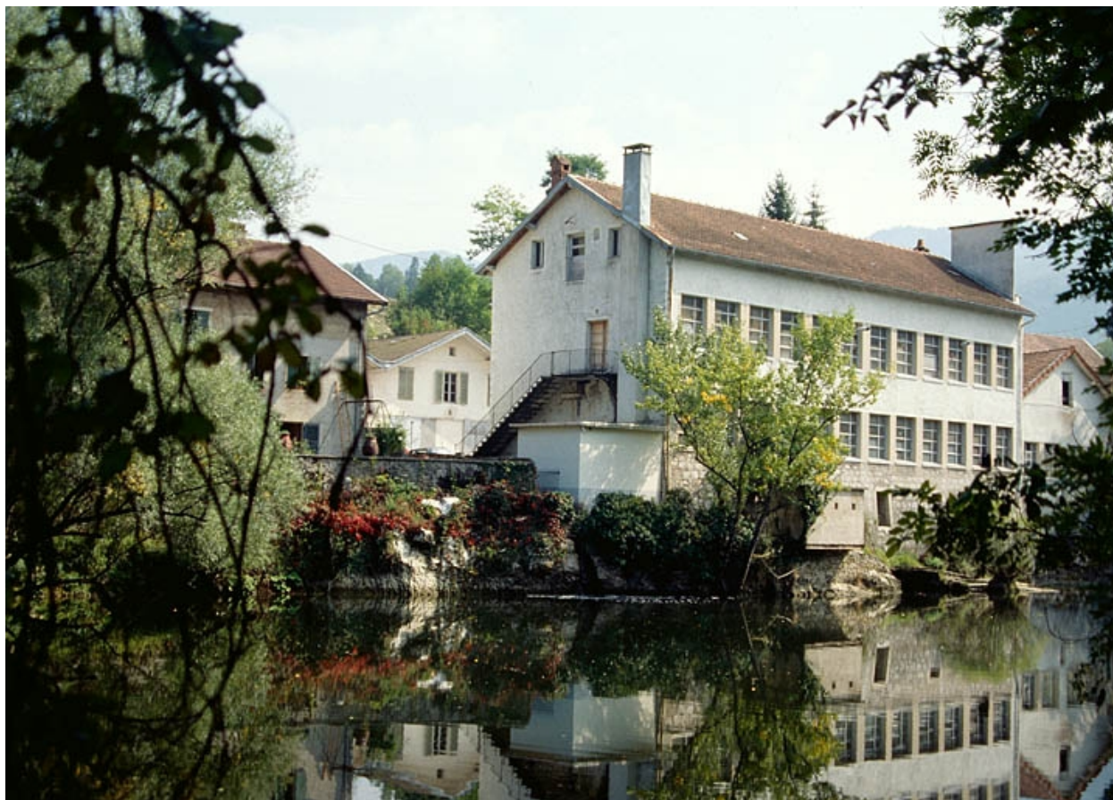
Atelier de fabrication, depuis le nord-ouest (aval).
