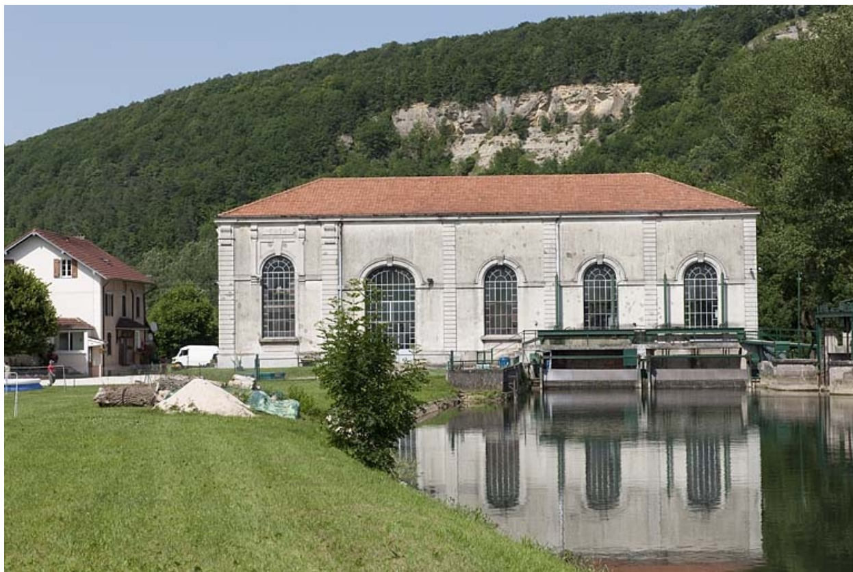
Façade sud de la centrale.
