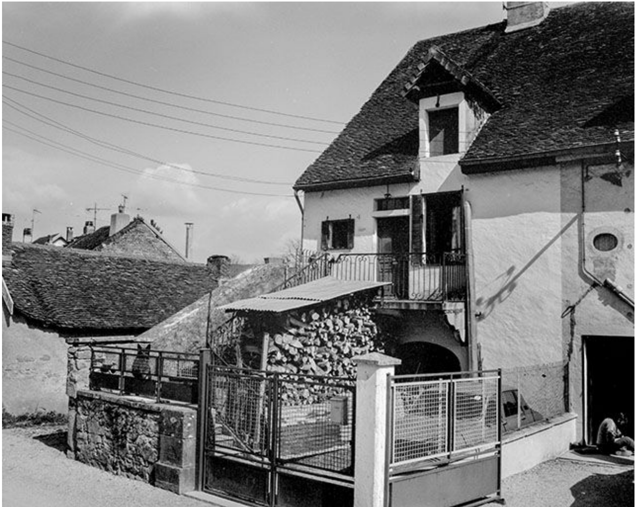
Maison de vigneron située rue de Montorient.
