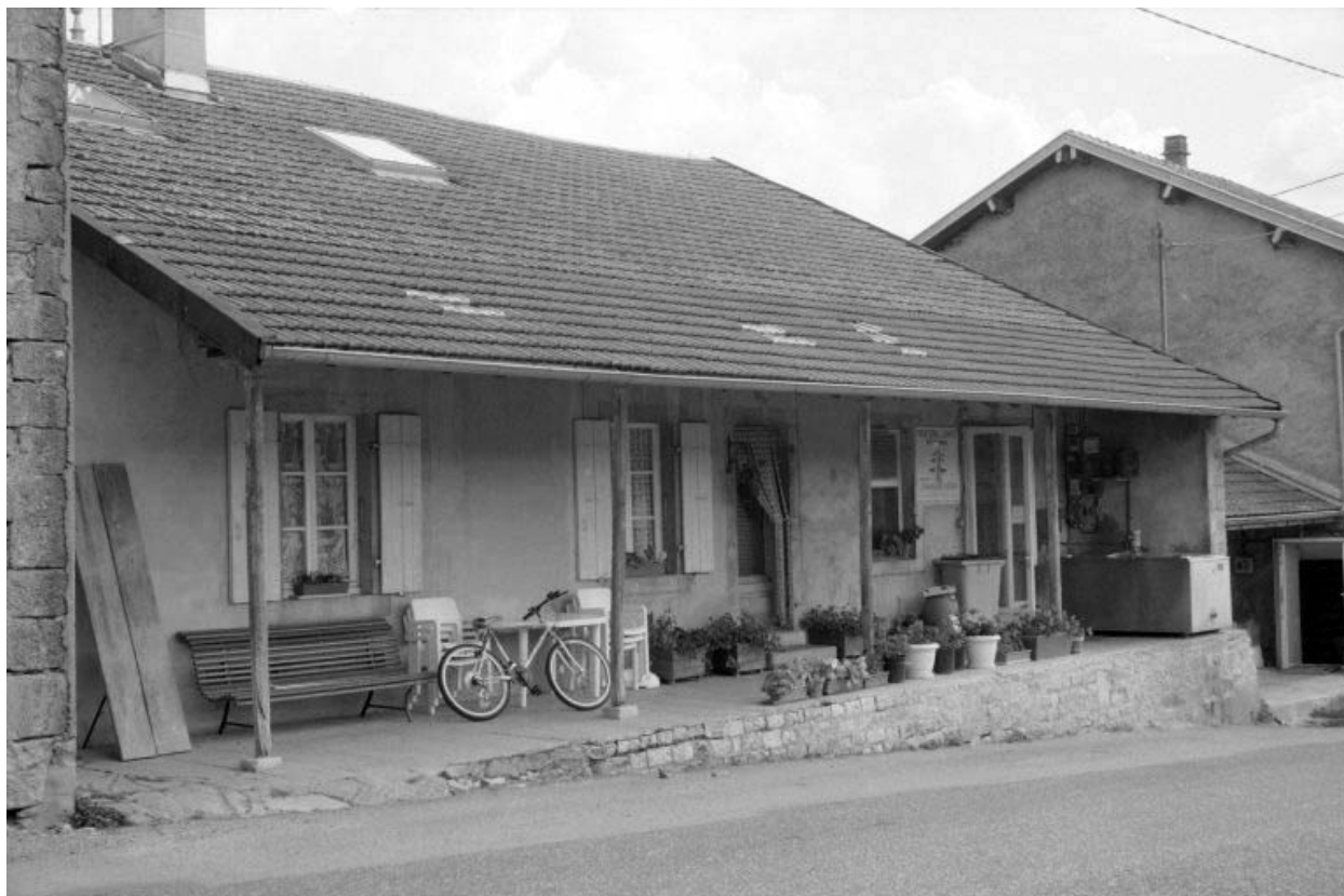
Façade antérieure de la fromagerie.
