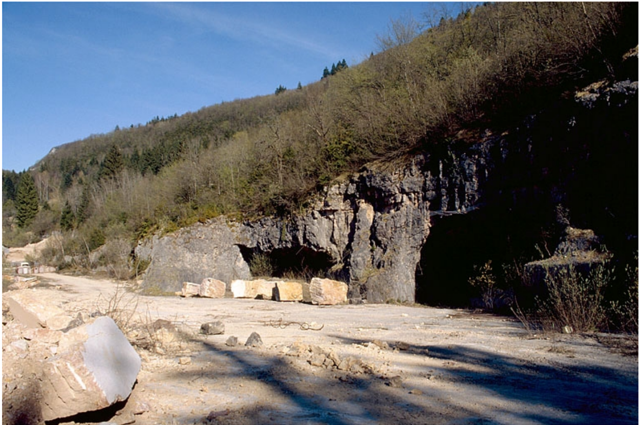
Carrière souterraine de Chassal : entrées de la partie sud-ouest.
