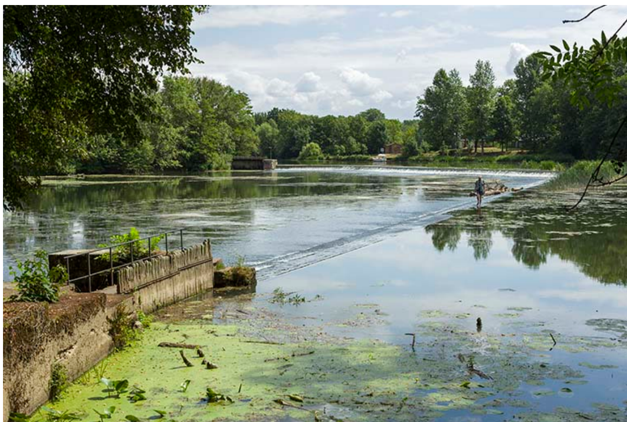
Ancien barrage usinier et la Saône.
