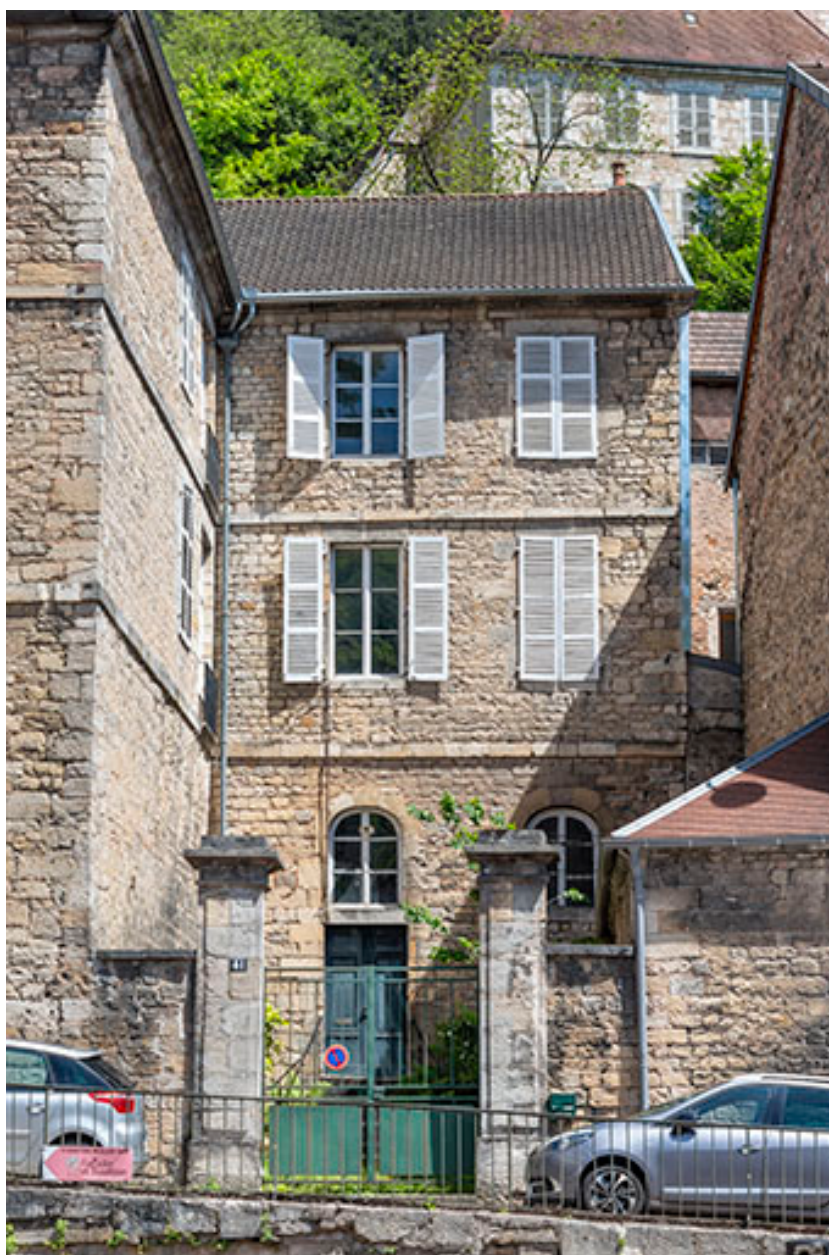
Façade ouest du bâtiment sur cour.
