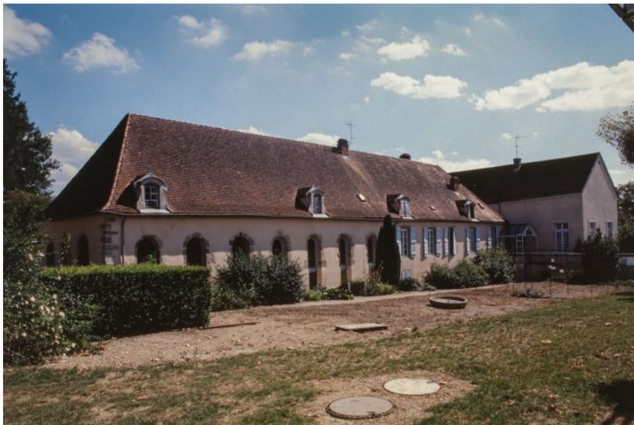
Vue générale de l'ancien hôpital, façade postérieure.
