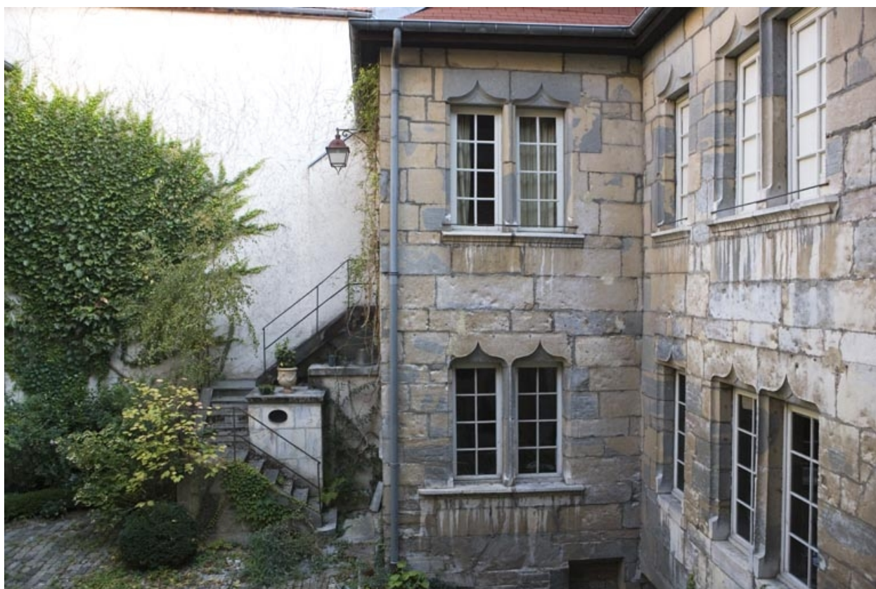
Aile du logis, façade latérale.
