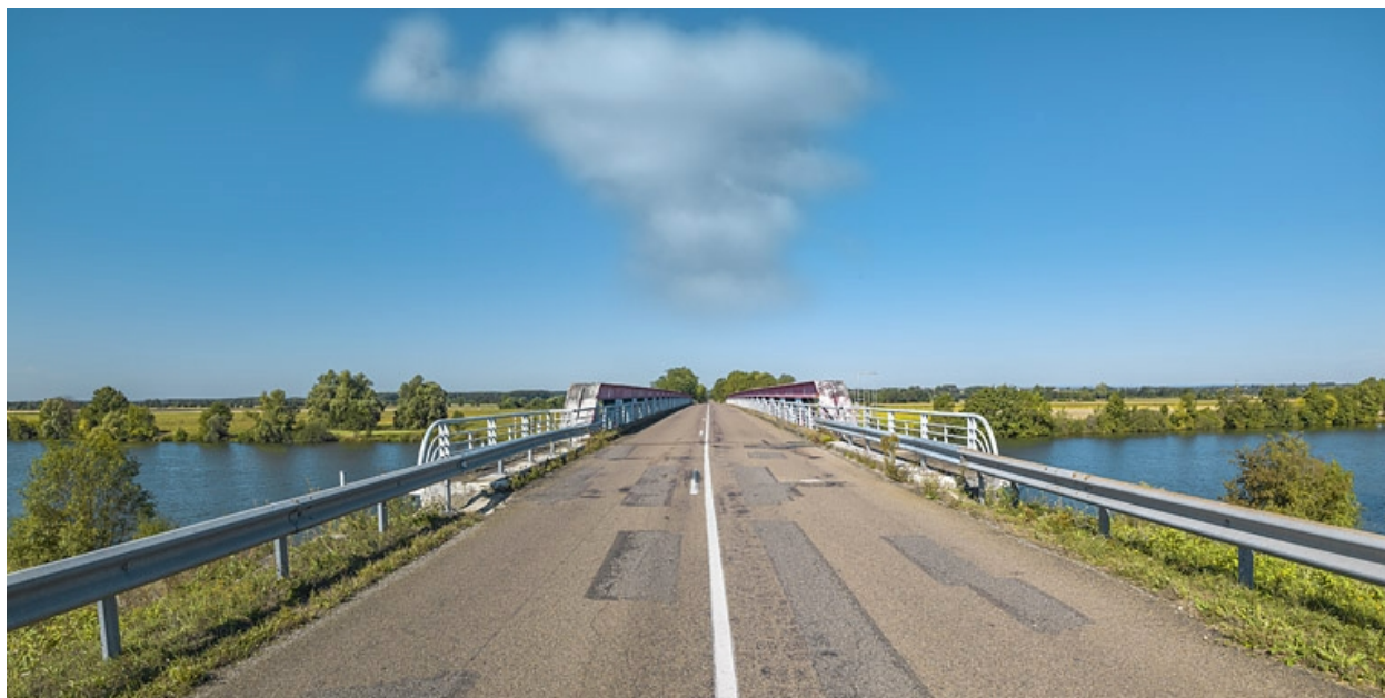
Vue d'ensemble du tablier du pont.
