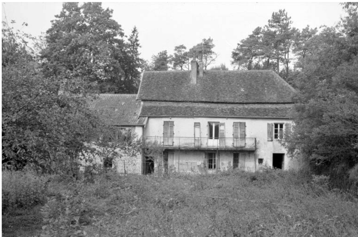
Façade latérale droite du logement patronal.
