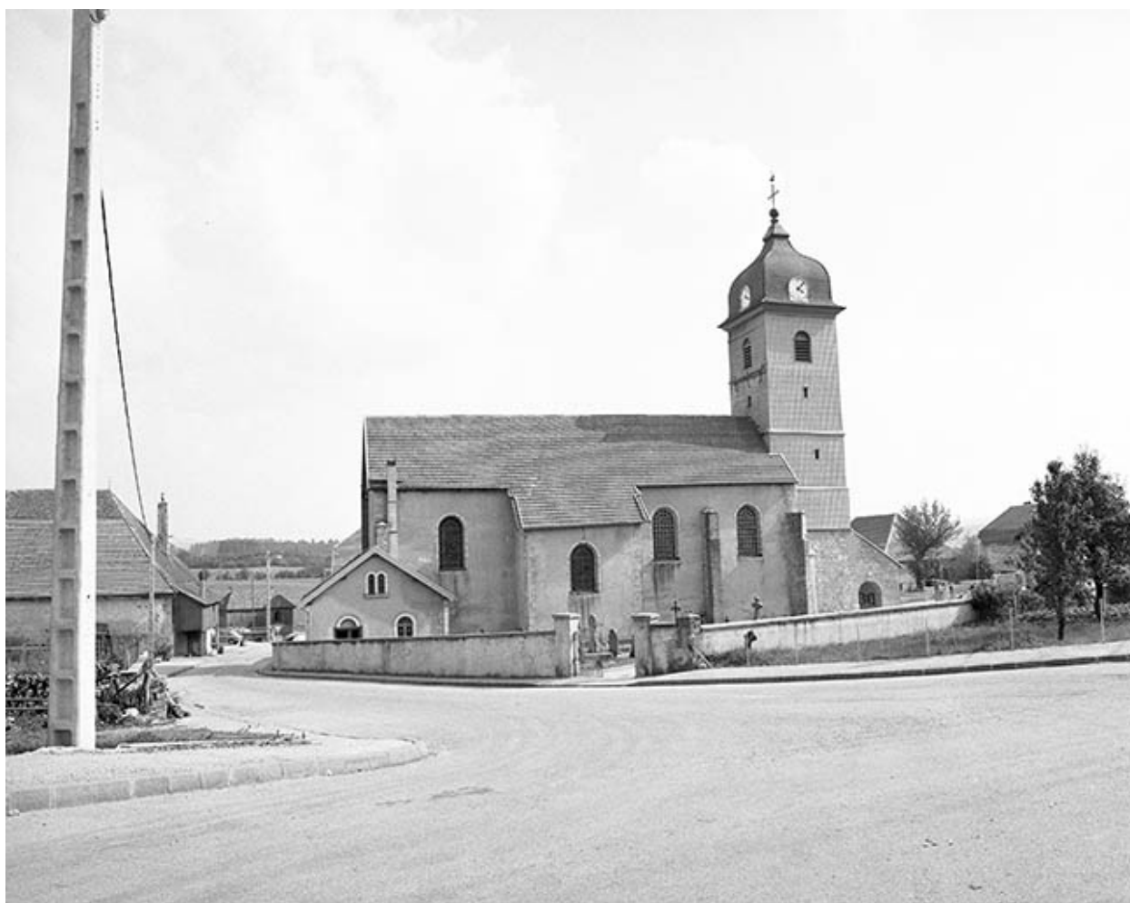
Extérieur : face latérale nord.
