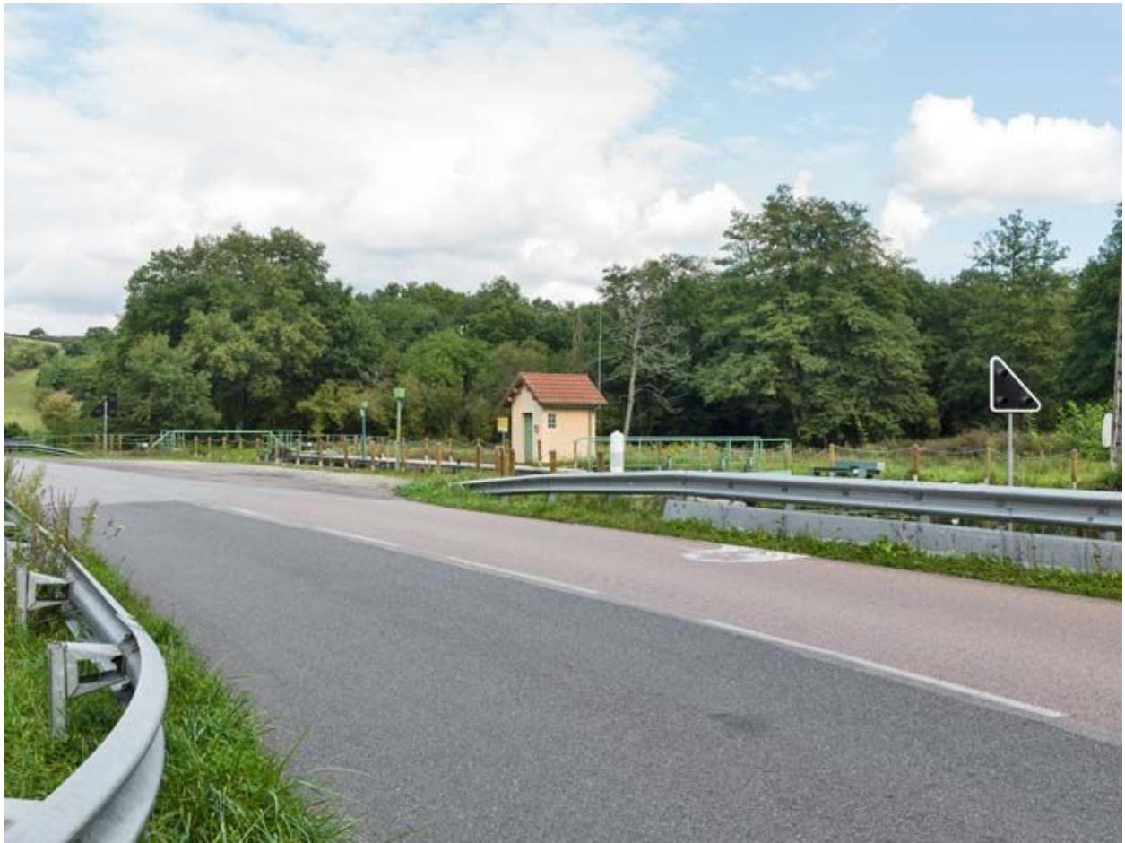
Vue d'ensemble du site d'écluse.
