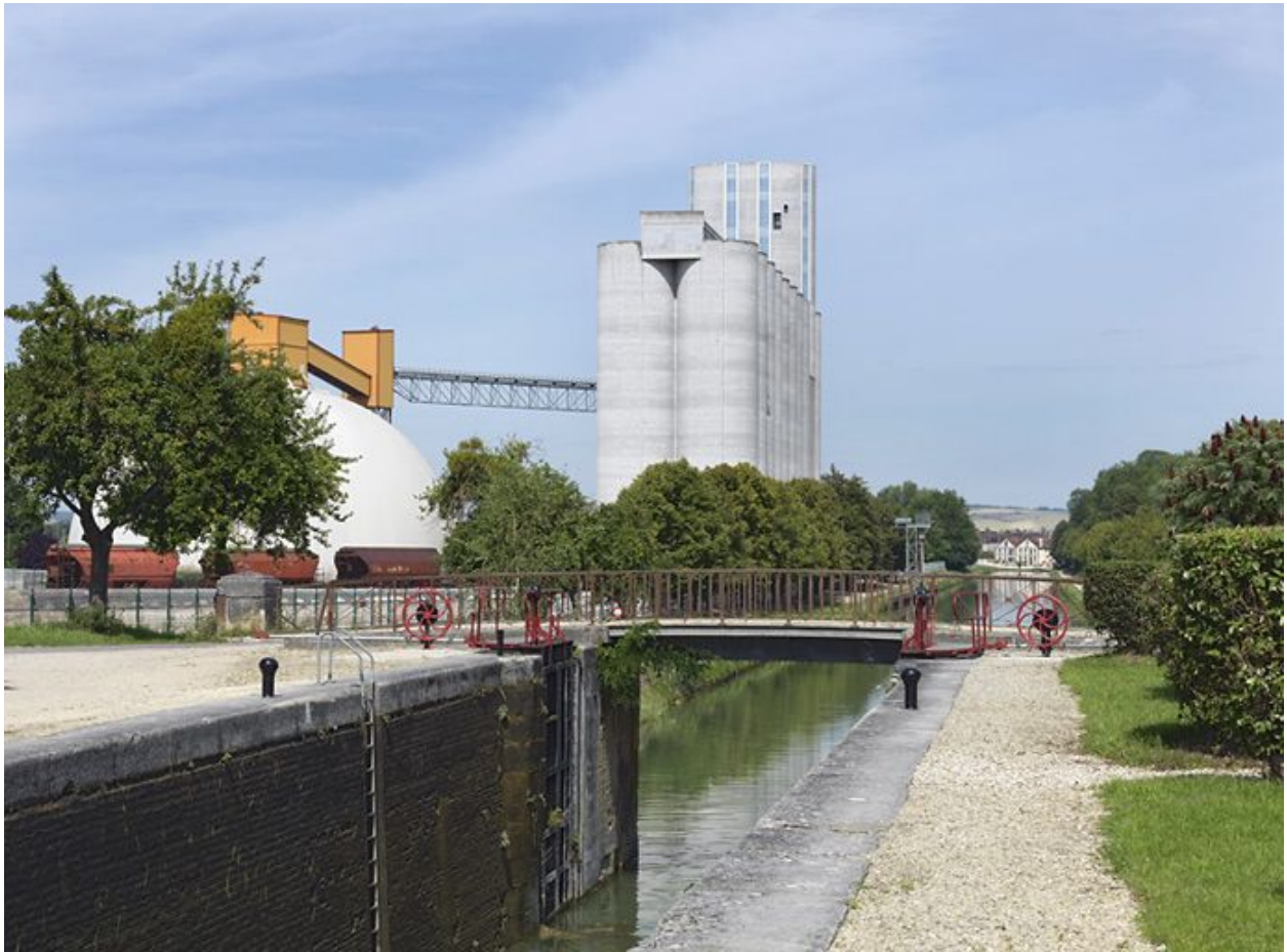
Pont vu d'amont. Silos en arrière-plan.
