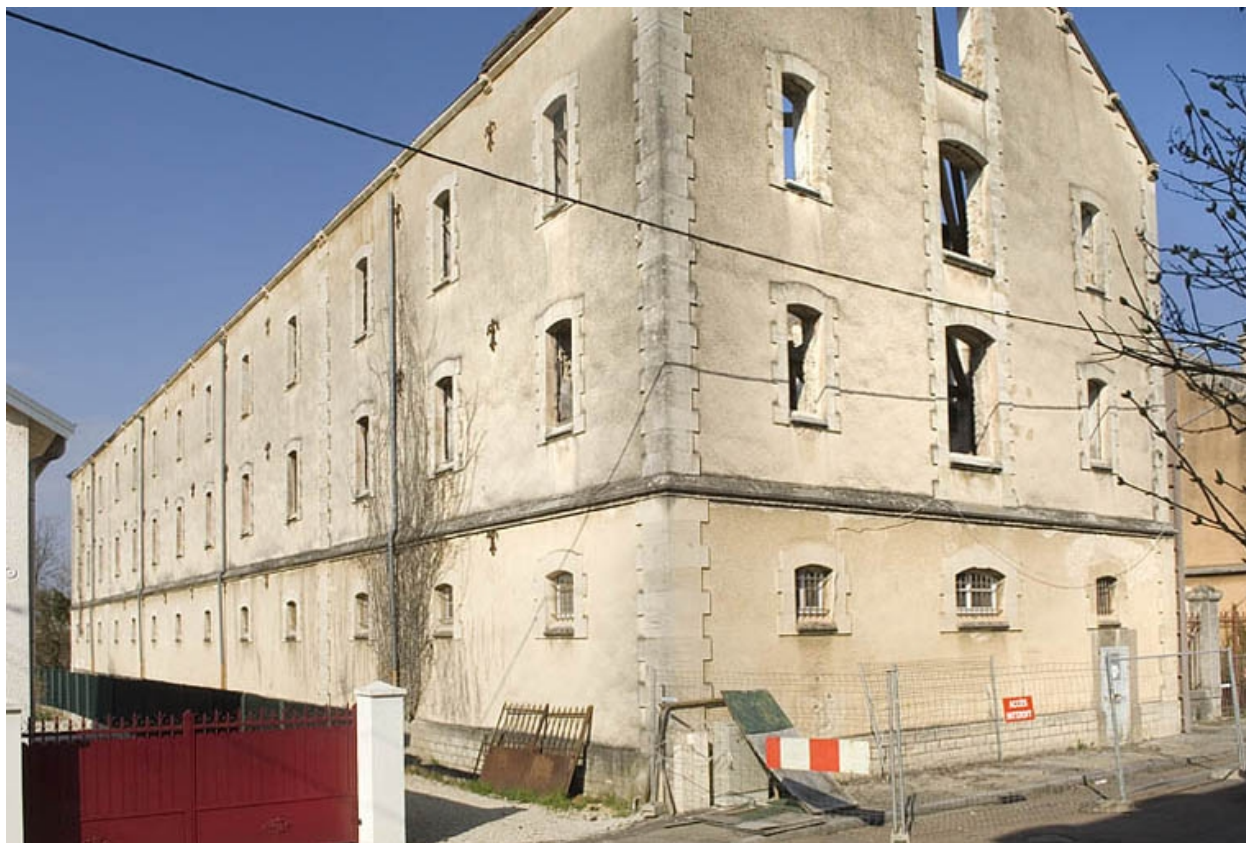
Aile ouest incendiée vue de trois quarts.
