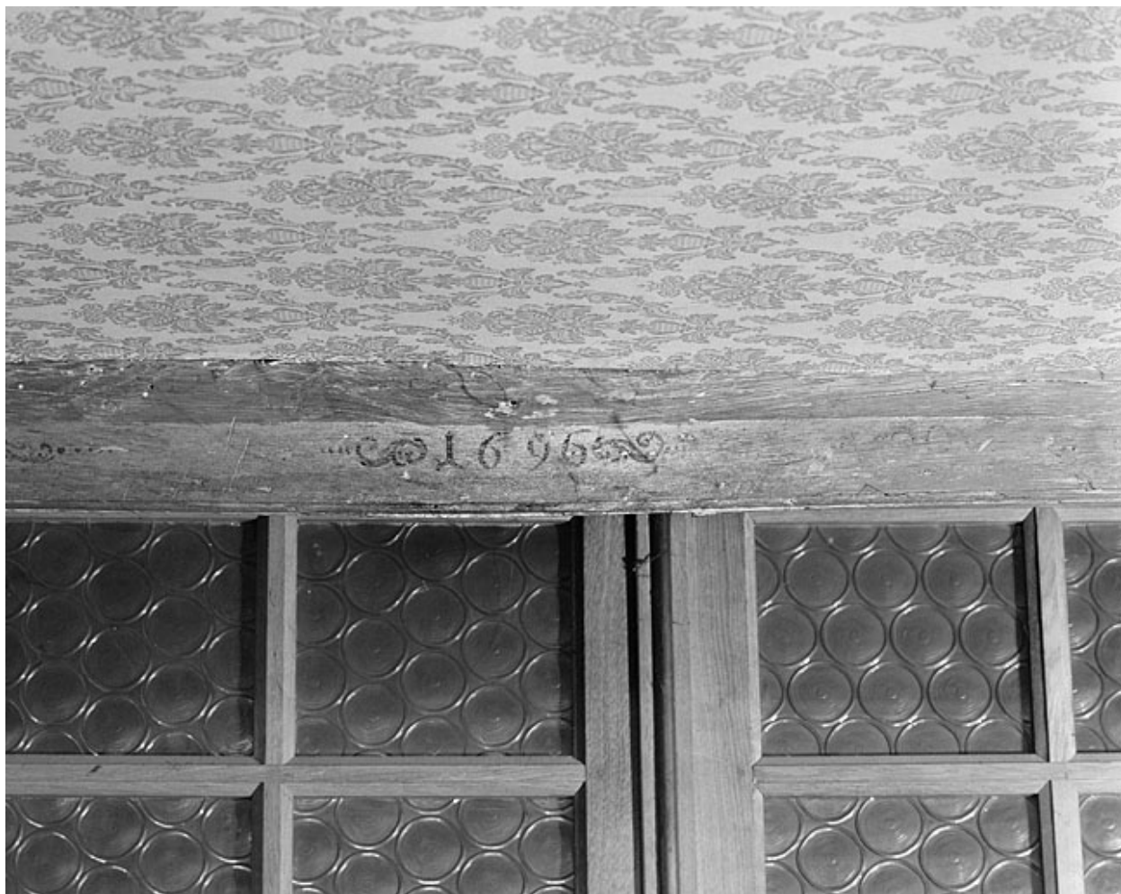
Premier corps de bâtiment. Plafond du rez-de-chaussée.
