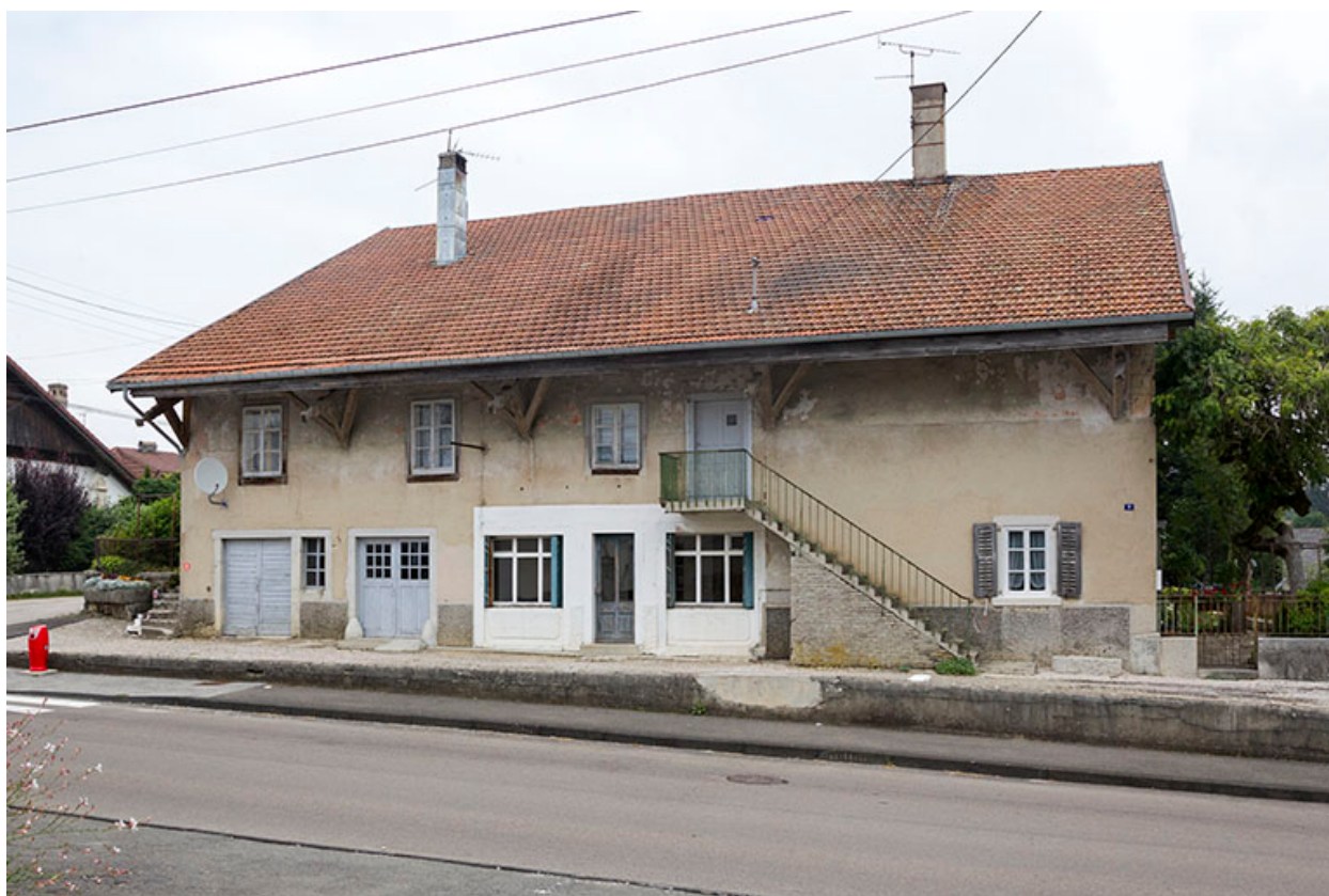
Façade latérale gauche.
